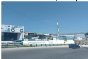
35.- Sobre el paso vehicular a desnivel del libramiento norte poniente que pasa debajo de la rotonda de la asta bandera, colonia Esperanza El Sabinito, Tuxtla Gutiérrez, Chiapas:
